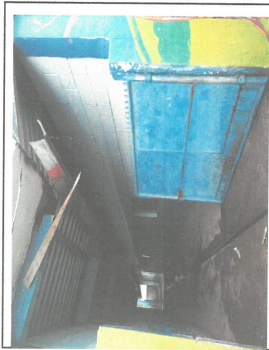
Foto 5: Sustitución de canal de metal por canal de PVC.
