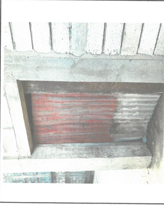
Foto 3: Sustitución de puertas de lámina por puertas de metal.
