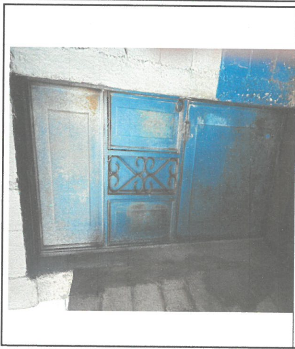
Foto 4: sustitución de puertas de metal por puertas de metal.
